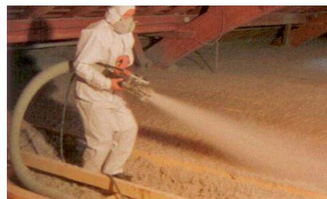
Isolation de plafond de l'église d'Amriswil (canton de Thurgovie, Suisse)
