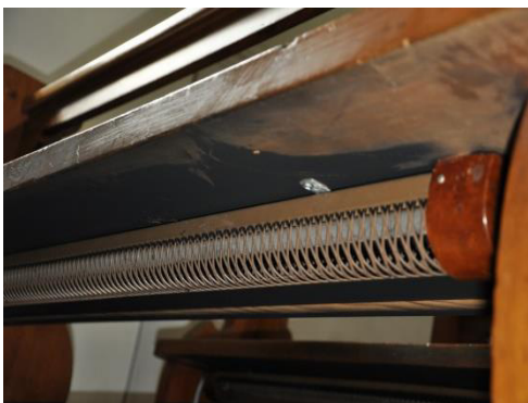
Chauffage sous les bancs
