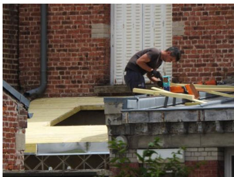
Les travaux d'isolation de toiture sont une priorité
